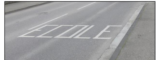
Marquage école sur chaussée à mettre sur une seule voie dans le sens de progression du véhicule (avec des lettres d'une hauteur minimum de 1,50m pour un axe inférieur ou égal à 50km/h).
