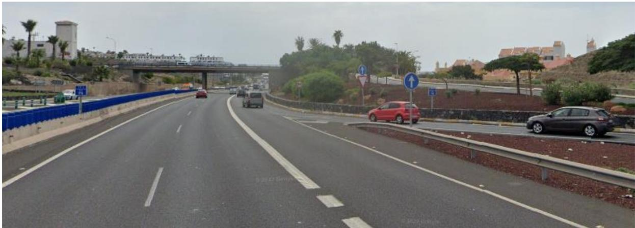
se puede ver que el **carril de salida y desaceleración** de la autopista **se cruza** con una entrada a la autopista, después de lo cual el carril de desaceleración se superpone con el carril de aceleración. En otras palabras, los que salen frenan frente a los que necesitan acelerar.
