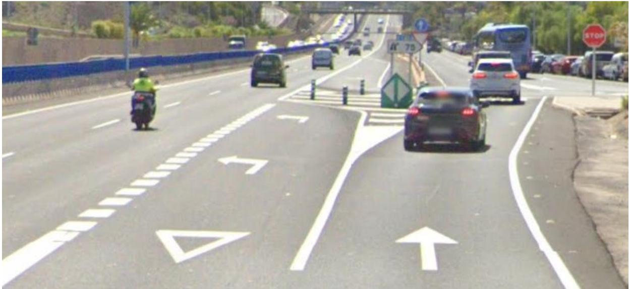
El carril de desaceleración (derecha) tiene una señal de Stop, para dar prioridad a otra entrada a la autopista, y el carril de aceleración (izquierda) está bloqueado por bolardos para evitar una mayor aceleración y superposición con la siguiente entrada a la autopista.
