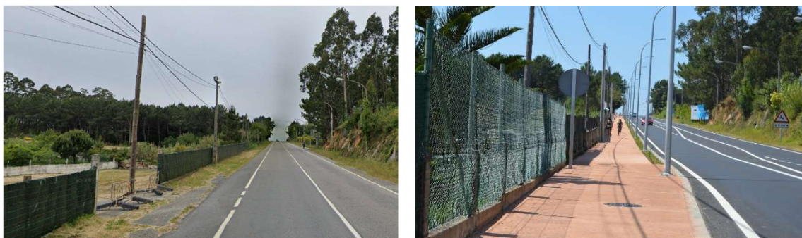
Imagen de la PO-308, antes y después de la actuación.
