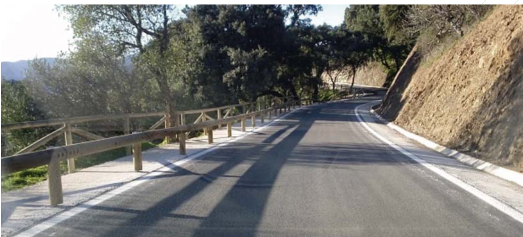
Foto 33: Compartiendo espacios de la carretera: A la izquierda senda peatonal, a la derecha cuneta pisable (Fuente: Diputación de Málaga)
