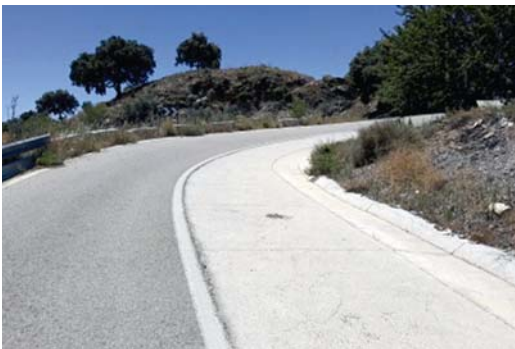
Foto 32: Efecto de la cuneta pisable ampliando la zona de rodadura de los vehículos evitando colisiones frontales y facilitando el cruce de vehículos (Fuente: Diputación de Málaga)
