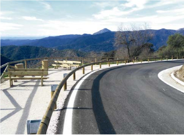
Foto 38: Distintas soluciones para mejorar la seguridad de los peatones en función del espacio disponible: de espacios segregados a cunetas pisables. (Fuente: Diputación de Málaga)
