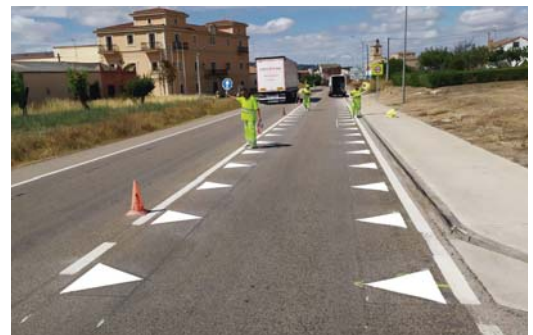
Foto 36: Actuaciones para la reducción de la velocidad en la travesía de la N-122 en Nava de Roa (Burgos). (Fuente: Ministerio de Transportes, Movilidad y Agenda Urbana)
