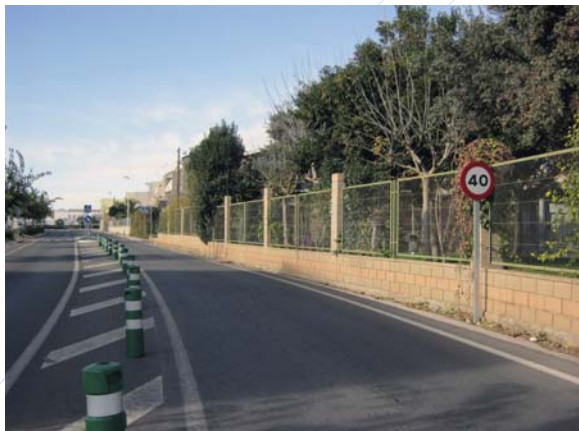
Foto 41: Balizamiento en mediana central en las proximidades de un paso peatonal. (Fuente: Diputación de Valencia)
