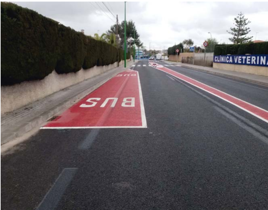
Foto 44: Parada de autobús en carretera.
