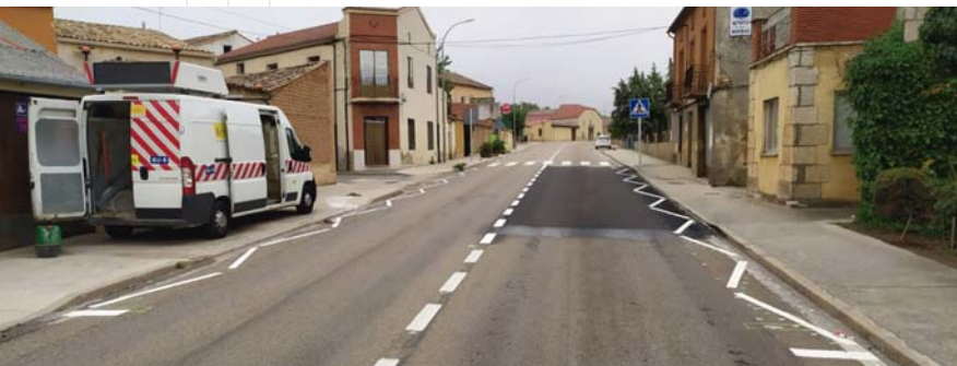
Foto 36: Actuaciones para la reducción de la velocidad en la travesía de la N-122 en Nava de Roa (Burgos). (Fuente: Ministerio de Transportes, Movilidad y Agenda Urbana)
