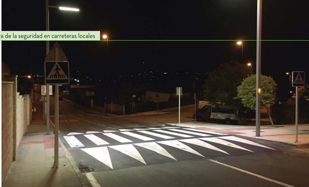
Foto 46: Paso peatonal sobreelevado con iluminación. (Fuente: Diputación de Pontevedra)
