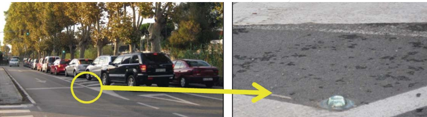
Foto 29: Utilización de captafaros embebidos en el pavimento (Fuente: Diputación de Barcelona)
