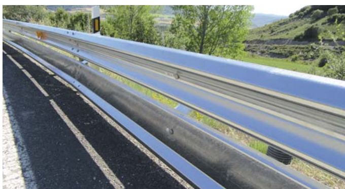
Foto 13: Sistema de contención para reducir las consecuencias de los accidentes por salida de vía; barrera de seguridad con sistema de protección de motociclistas (Fuente: Gonvarri)
