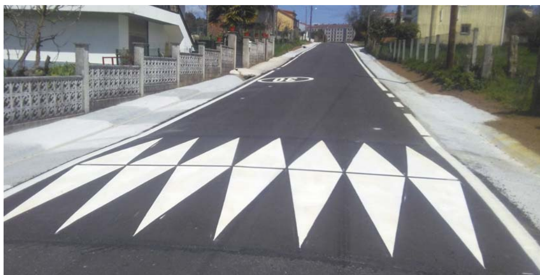
Foto 30: Cuneta pisable (Fuente: Diputación de Pontevedra)
