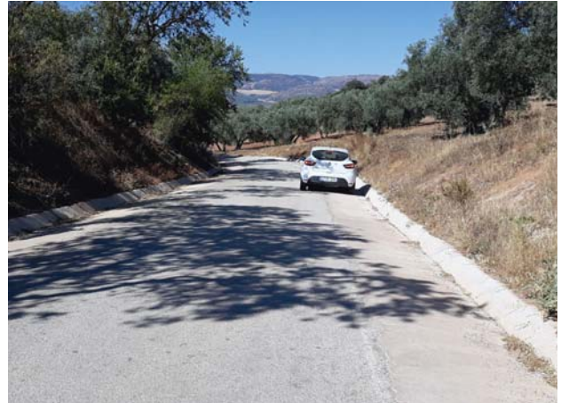
Foto 38: Distintas soluciones para mejorar la seguridad de los peatones en función del espacio disponible: de espacios segregados a cunetas pisables. (Fuente: Diputación de Málaga)
