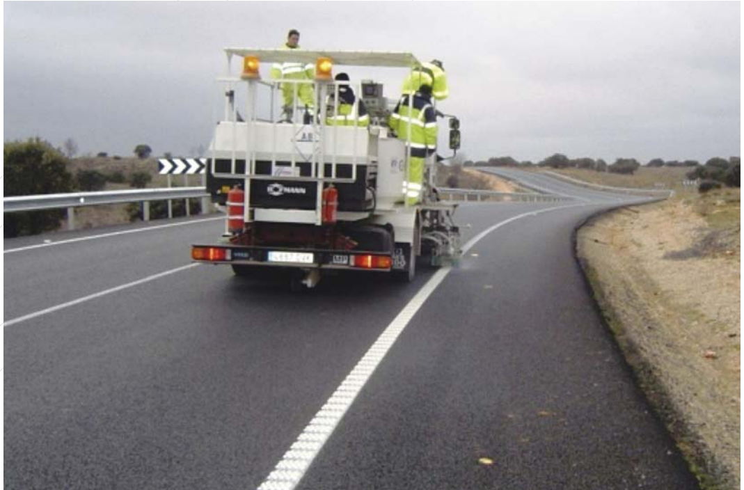
Foto 27: Marca vial de borde con resalto (Fuente: FAPLISA)
