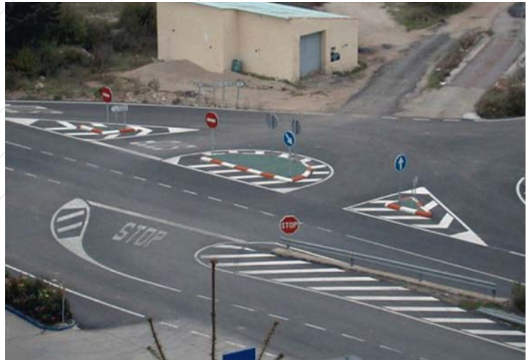
Foto 14: Intersección con elevada carga de trabajo y probables dificultades de interpretación
