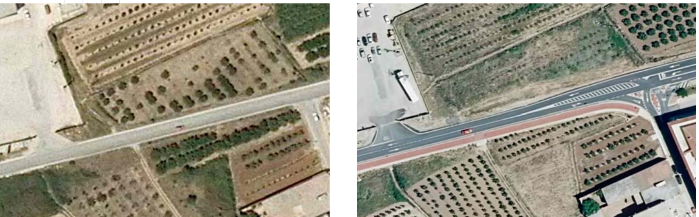
Foto 35: Acondicionamiento de intersección (Fuente: Diputación de Valencia)
