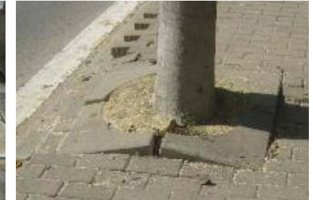
Raíces que levantan el pavimento
