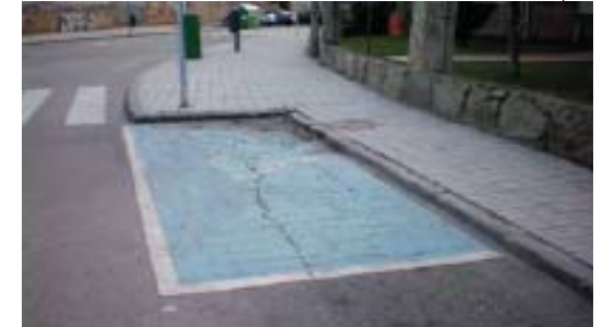
Ausencia de rampas para acceder a la acera
