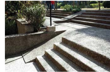
Pendiente excesiva (supera al 6%), falta barandilla, resalto excesivo, irrupción en itinerario en la parte superior.
